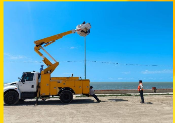
Mantenimiento y cambio de luminarias en Isla Arena
